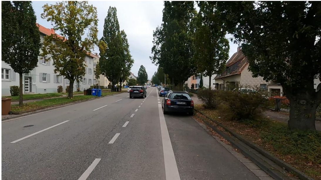
Abbildung 17: Beispiel Schutzstreifen und fehlender Sicherheitstrennstreifen Blocksberg Str. Pirmasens
