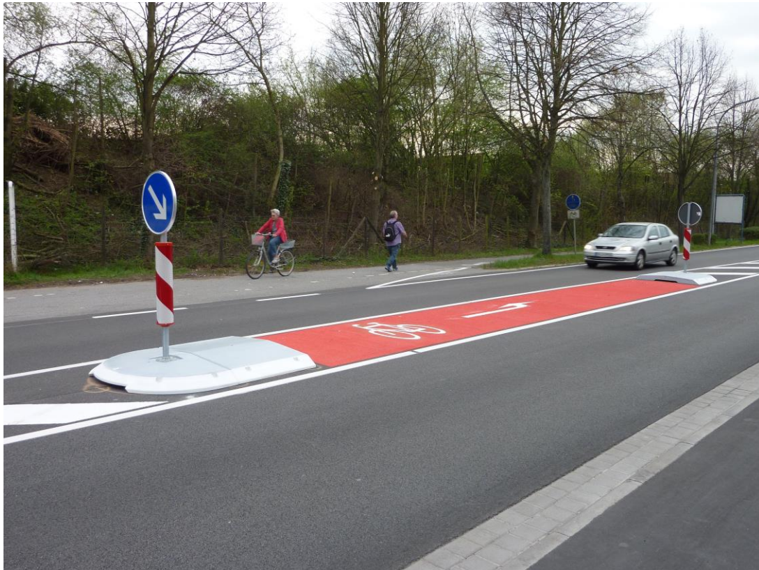
Abbildung 19: Beispiel einer Mittelinsel mit Aufstellfläche zum Linksabbiegen (Hertenheim) Fahrradfreundliche Nebenstraßen (Tempo 30-Zonen, Fahrradstraßen)
