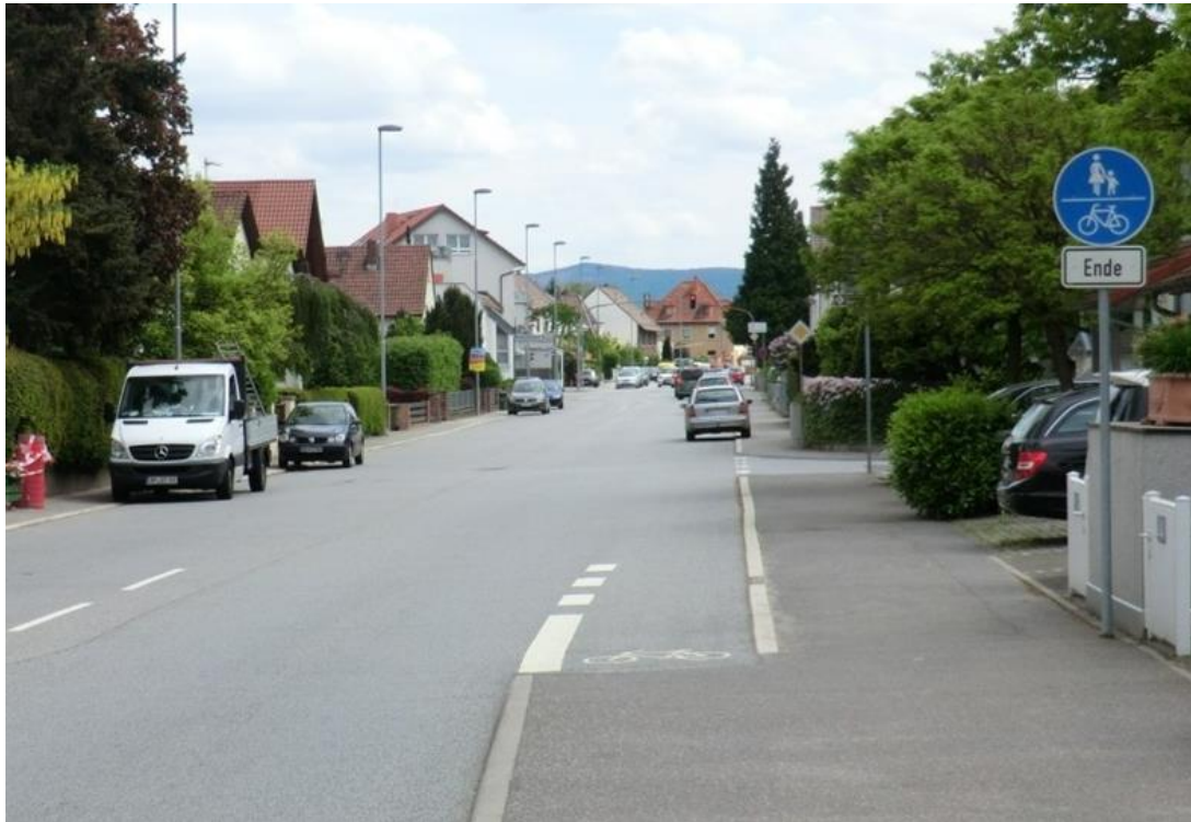
Abbildung 16: Beispiel einer markierten Ausleitung auf die Fahrbahn (Ilvesheim)
