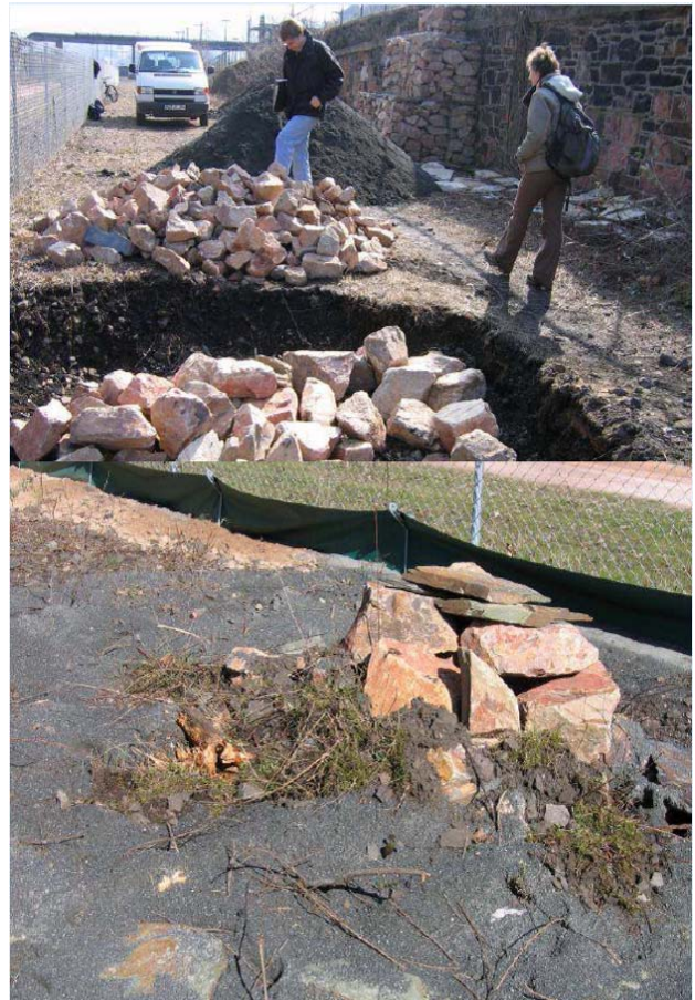
Abbildung 7: Anlage einer Steinlinse; Quelle: http://www.karch.ch/karch/upload/File/Praxismerkblatt_Kleinstruktur_Steinlinsen(1).pdf und: Grontmij GmbH, Koblenz: Die Zauneidechse, eine verbreitete Art von hohem planerischen Gewicht.
