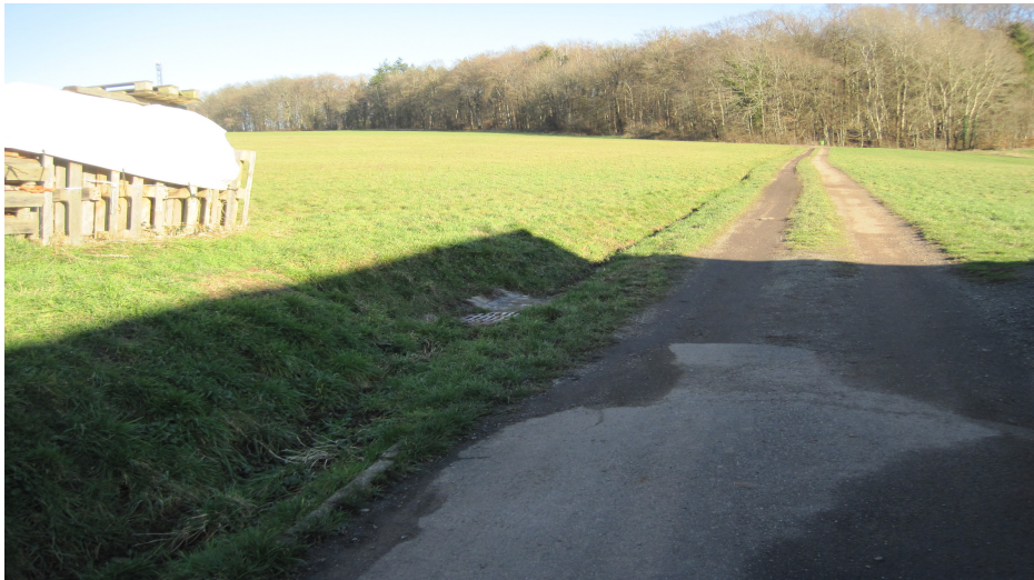
Blick Richtung Osten, bestehender Wirtschaftsweg
