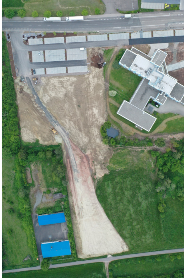
Drohnenaufnahme Erdarbeiten 14.5.2020 (Quelle: privat)
