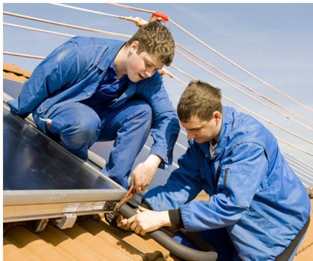
WHG Rahn-Mitarbeiter bei der Installation einer Solaranlage zur Warmwasserbereitung
