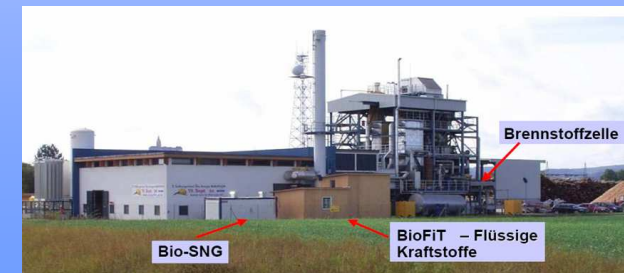
Wasserdampf-Vergasungsanlage, Güssing (Österreich)
