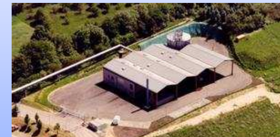
Bioabfallvergärungsanlage, Durlach (Baden-Württemberg)
