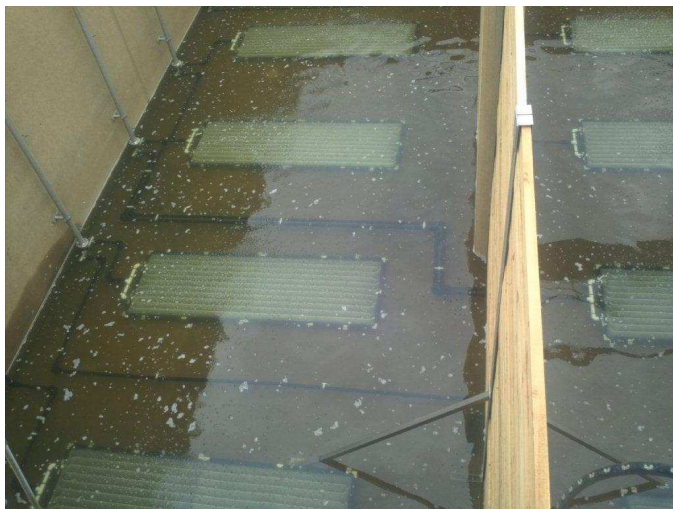
Abbildung 23: Beispiel Lärchenholz-Trennwand
