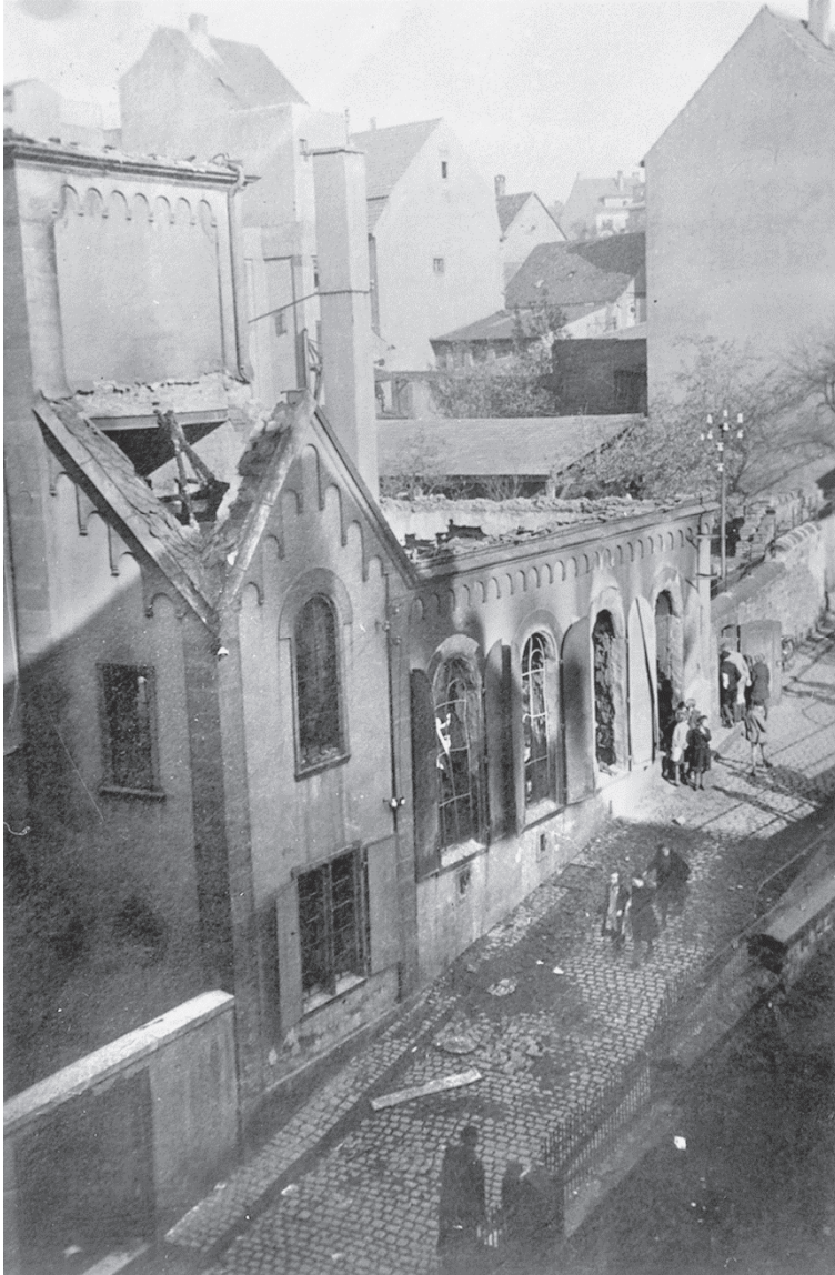
Die in der Pogromnacht, am 9./10. November 1938 niedergebrannte Pirmasenser Synagoge
